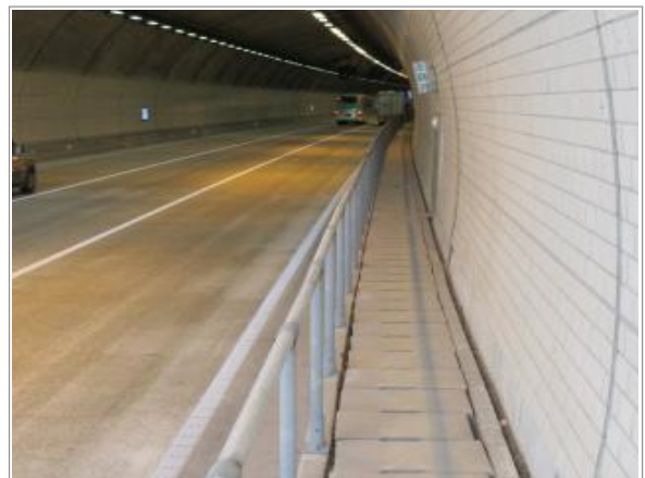
공동구 및 배수로 전경(주행선측)
