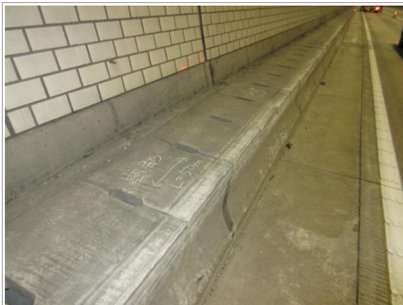
공동구 및 배수로 전경(추월선측)
