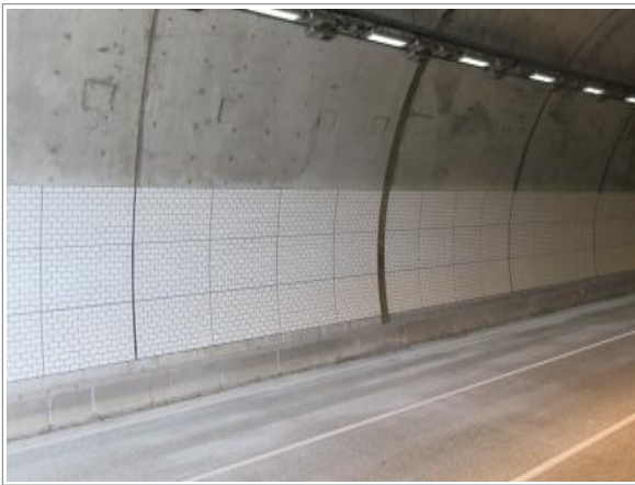
측벽부 타일마감 전경(추월선)
