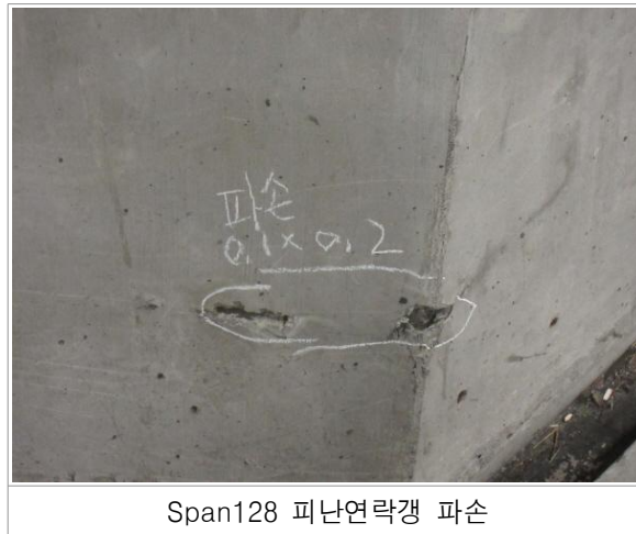
〈사진 3.28〉 피난연락갱(포항) 외관조사 현황
